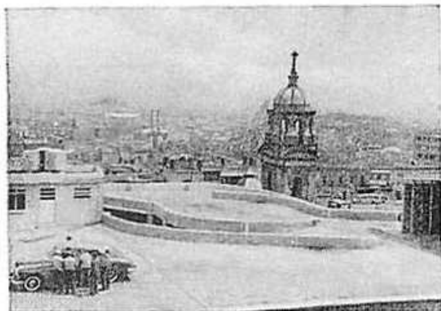
Станция обслуживания на крыше пятиэтажного гаража в Мехико.
